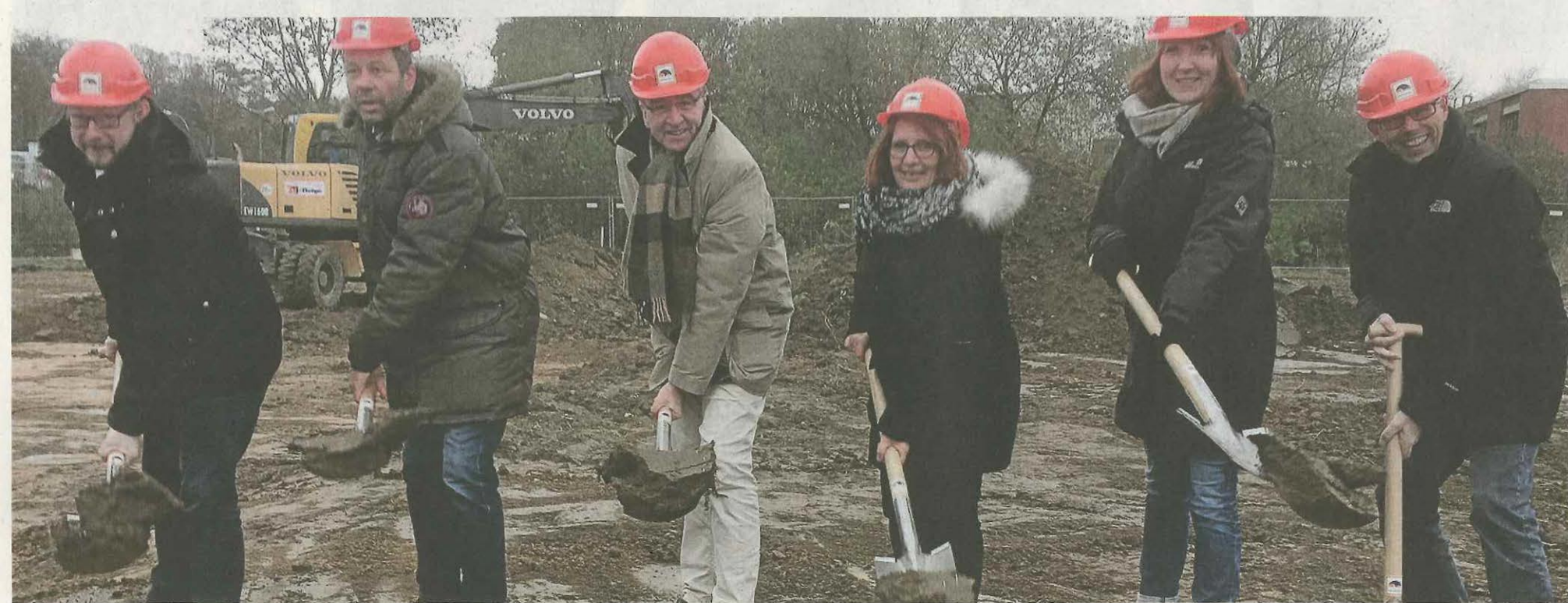
Ivica Lucanic, Thomas Möhlendick, Thomas Pink, Claudia Hesebeck, Olga Schell und Knut Foraita (von links) beim ersten Spatenstich für den neuen Kindergarten Am Sonnenhang. Ende nächsten Jahres soll das Gebäude fertig sein.
