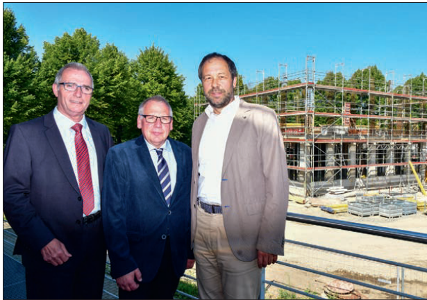
Vorstandssprecher Ernst Gruber, Michael Baumgarten, Abteilungsleiter Facility Management, sowie Architekt Thomas Möhlendick geben einen Einblick in den Baufortschritt und den Zeitplan.
