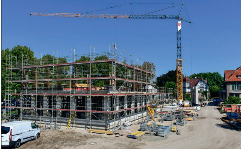
Die schnell voranschreitenden Bauarbeiten am Herzogtore sind nicht zu übersehen. Bereits Ende des Jahres soll der Rohbau fertiggestellt werden. Fotos: I. Stute
