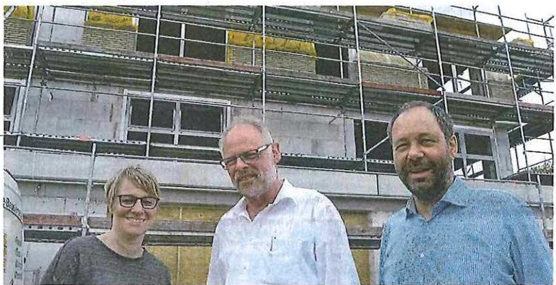
Grund zur Freude haben (von links) Petra Sandmann, Bernd-Georg Kuder und Thomas Möhlendick: Der Neubau der Kindertagesstätte Am Sonnenhang macht gute Fortschritte. Man erkennt im oberen Bereich schon die helle Ziegelfassade. Anfang 2018 soll Einzug sein.
