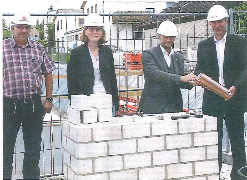
Grundsteinlegung an der Ottmerstraße: (von links) Marius Brauner von Kümper und Schwarze, Silke Pfortner von der Wiederaufbau, Ivica Lukanic sowie Torsten Böttcher.
