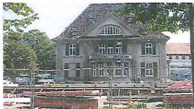
Auch die Arbeiten an der ehemaligen Welger-Villa haben bereits begonnen.
