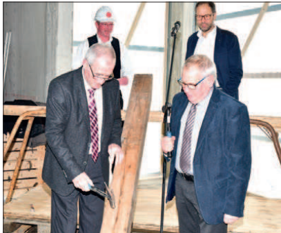
Ernst Gruber und Michael Baumgarten schlugen den Nagel beim Richtfest in den Balken.
