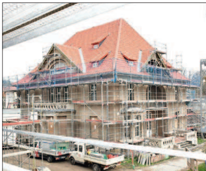
Noch eingerüstet: Die Welger-Villa neben dem neuen Gebäudekomplex wird restauriert.
