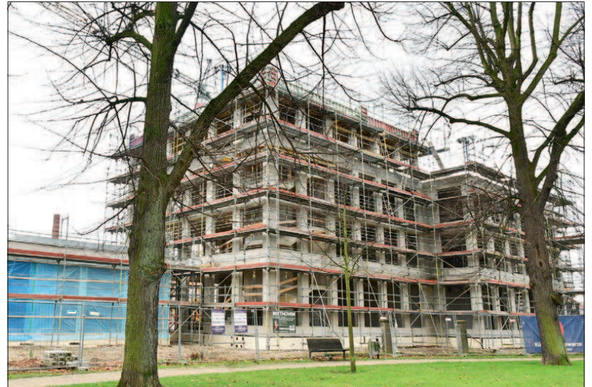
Noch nicht fertig, aber schon gut erkennbar: Der neue Gebäudekomplex Am Herzogtore ist für jeden sichtbar.
